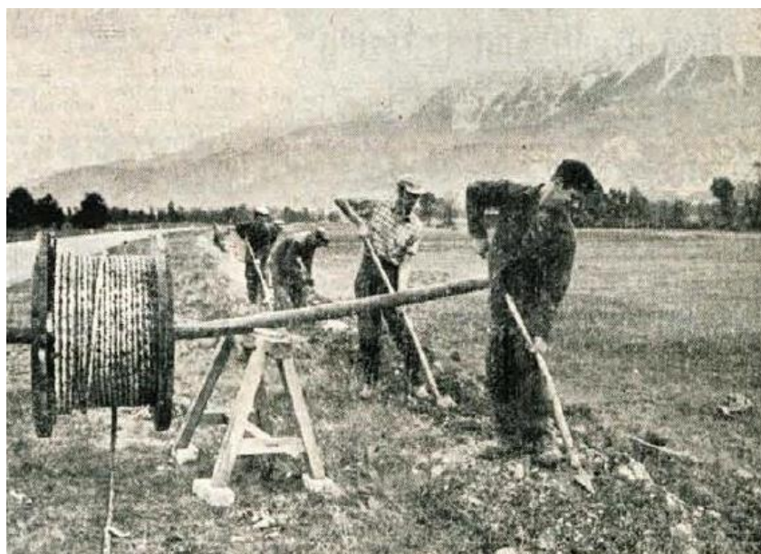
Polaganje telefonskega kabla v Lescah (Lesce-Žirovnica) Glas Gorenjske, 17. 10. 1960
